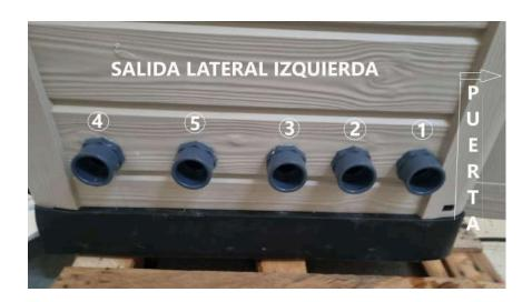
**IMPORTANTE**, las conexiones a los tubos de la depuradora se indican con los números 1, 2, 3, 4 y 5 correspondiendo **1, 2 y 3 al Fondo, Limpiafondos y Skimmer indistintamente** (por donde se aspira agua de la piscina, agua que hay que depurar).
