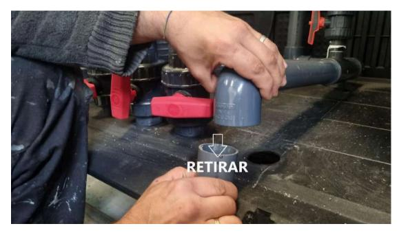
**IMPORTANTE**, para el transporte de la depuradora Salida a Suelo, las salidas de los tubos de Fondo, Limpiafondos, Skimmer (1, 2 y 3), Retorno o Boquillas (4) y Desagüe (5) tienen metido un trocito de tubo PVC sin pegar. Se debe retirar y pegar el definitivo.
